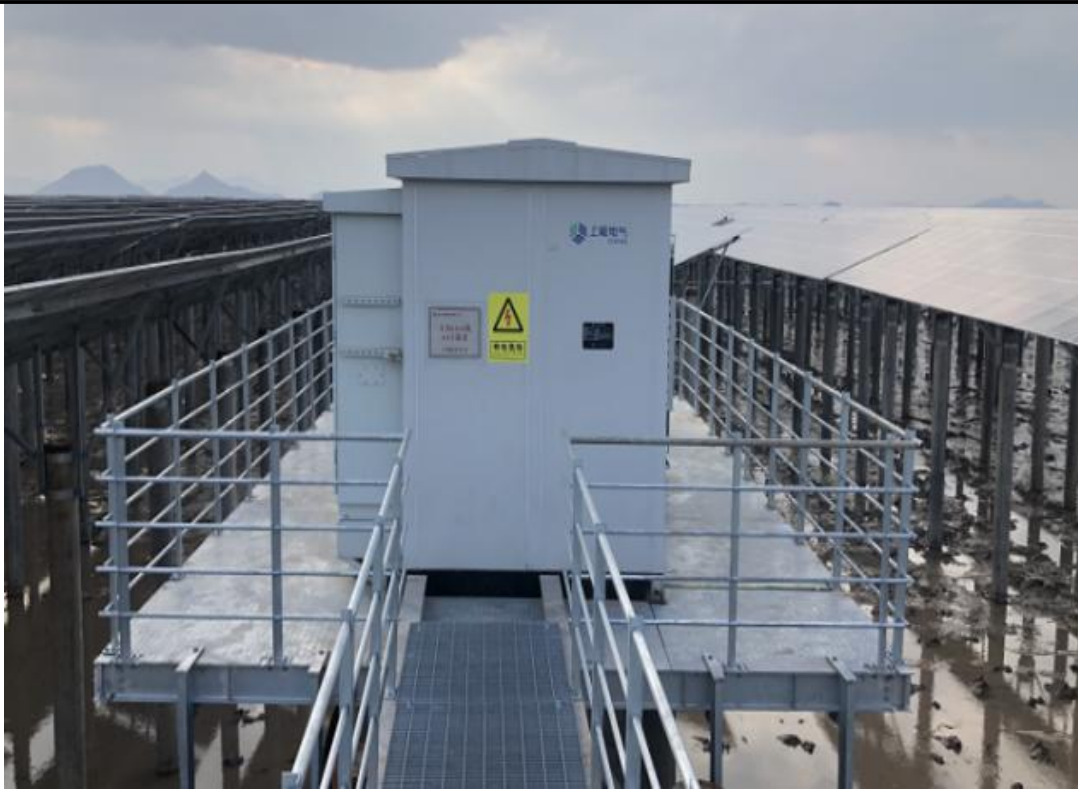
图 2-4 箱变基础平台示意图
