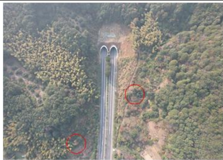
隧道进口现状
