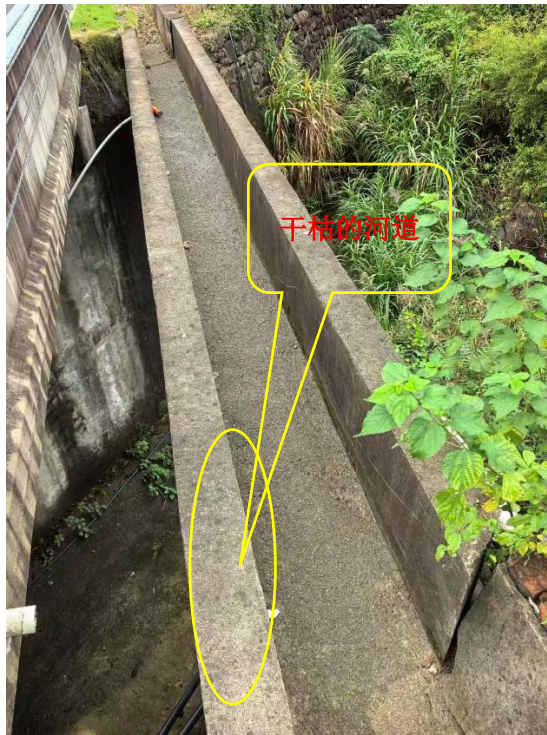
图 3-5 干枯的大化水库上游河道
