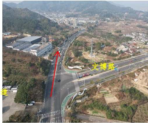
图 3-7 K0+682 段沿线现状
