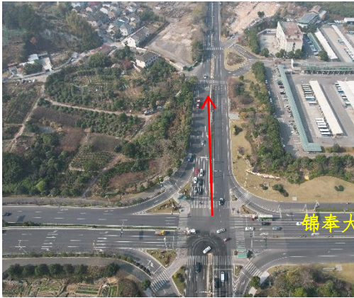
图 3-6 K0+000 起点现状
