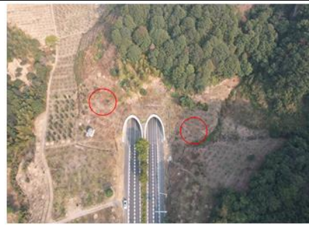
隧道出口现状
